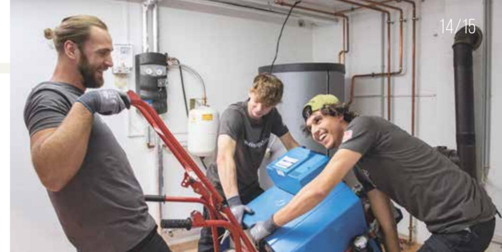
Wenn der alte Ölkessel rausmuss, können auch Wärmepumpen als ökologische Heizsysteme ihren Platz im Keller einnehmen. Besonders wichtig dabei: Das Haus muss gut gedämmt und die Wärmepumpenanlage extrem gut geplant sein.
