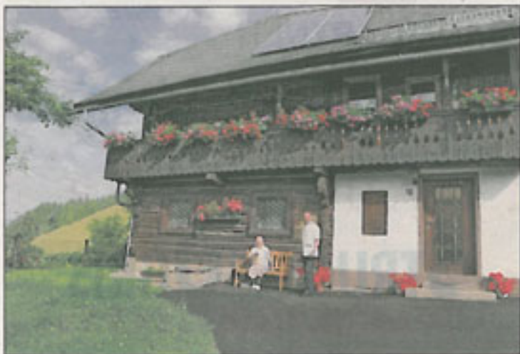
Die PV-Anlage in Arrlach bringt 920 € Stromvergütung pro Jahr
