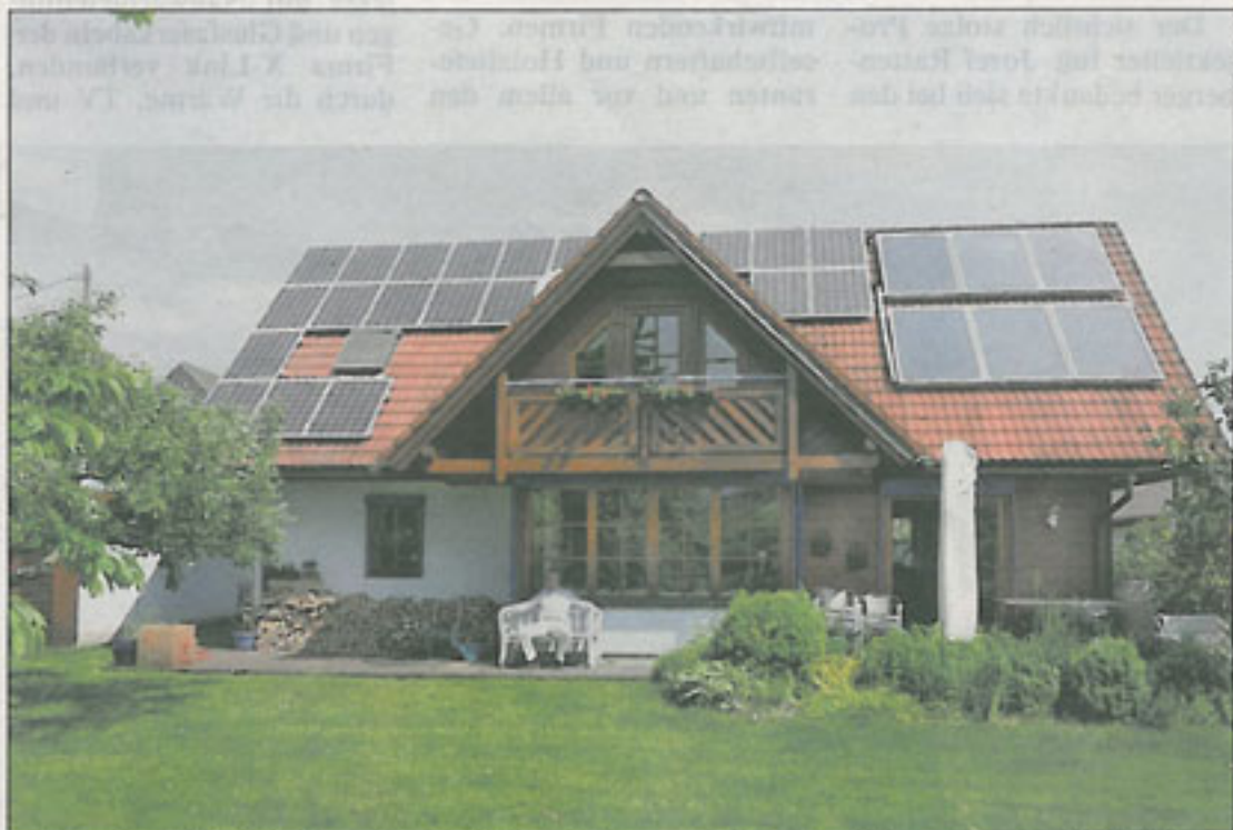
Die 33 m 2 Modulflächen auf einem Haus in Vitring sorgt für einen Jahresertrag von 5000 kWh
