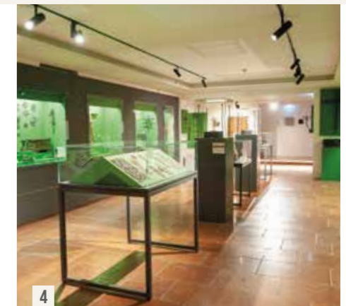
4 Im Erdgeschoß und im Untergeschoß des Thurnhauses Leogang verbirgt sich eine Fußbodenheizung unter den Marmorböden.
