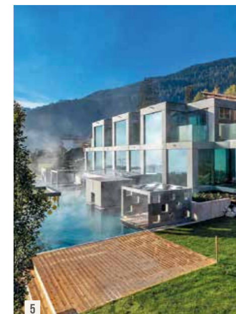
5 Das MOHR life resort in Lermoos ist mit einer supereffizienten Gebäudekühlung (Erdsonde mit Tiefenbohrung) ausgestattet.
