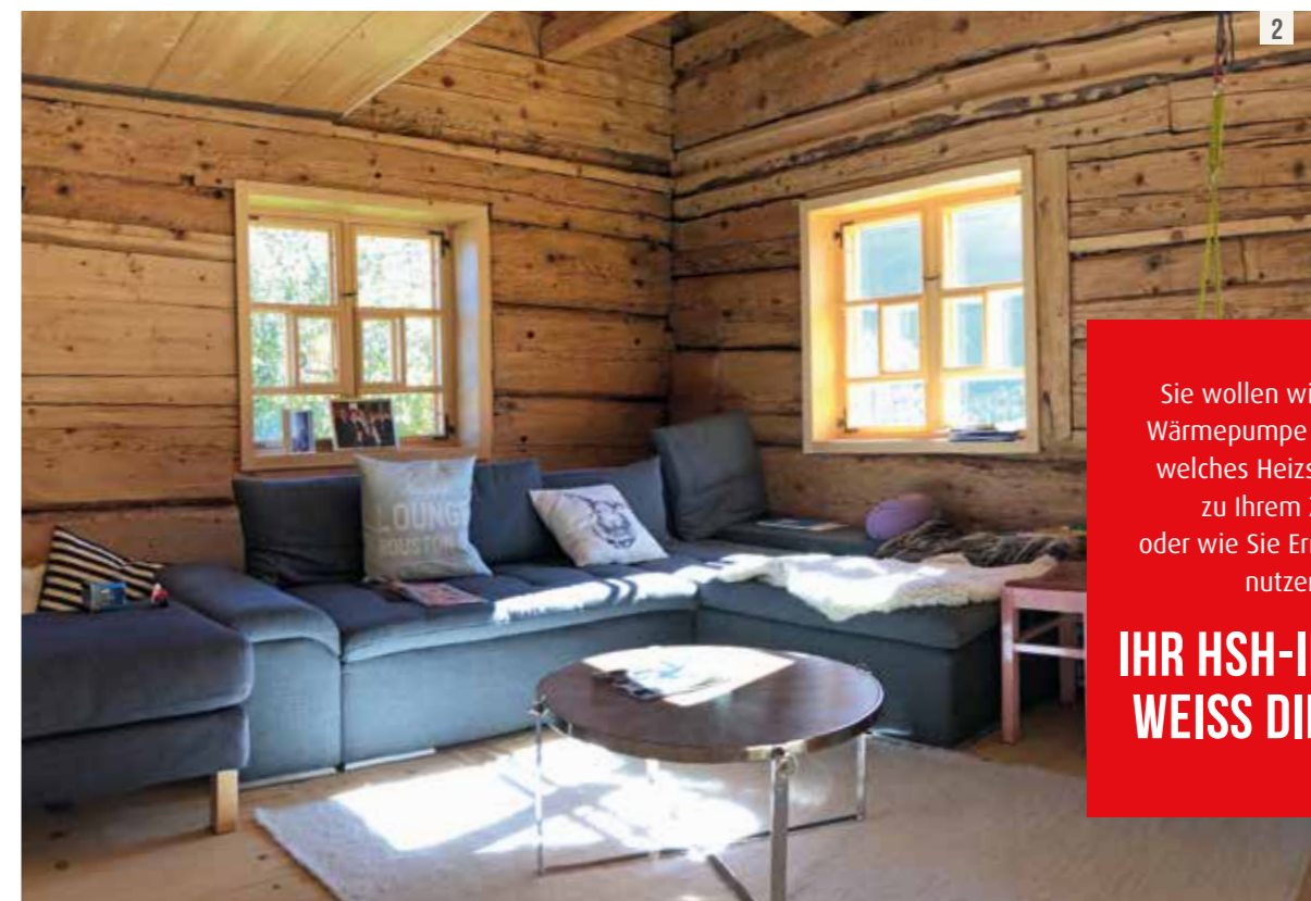
2 Die Trägerplatten der Fußbodenheizung in diesem Haus aus dem 15. Jahrhundert bestehen aus ökologischen Weichholzfasern.
