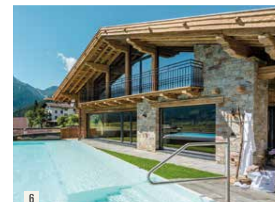
6 Die Gäste des Hotels Post genießen die angenehme Temperatur des Saunabodens, der über ein modernes Flächensystem gekühlt wird.
